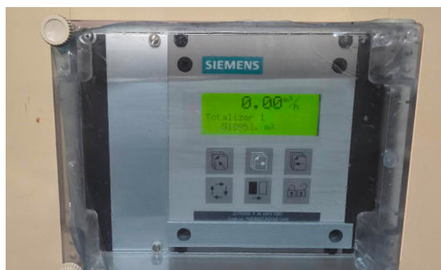
ภาพที่ 6-7: เป้าหมายที่ 6 Electromagnetic flow meter ที่ในการติดตามการเก็บข้อมูลการใช้น้ำ
