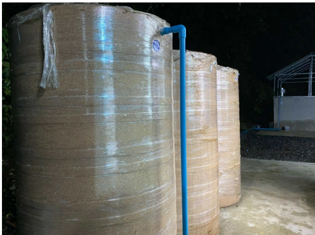
ถังเก็บน้ำทะเลสะอาด เพื่อใช้ในระบบเพาะฟัก ขอรับการสนับสนุนจาก ปตท.สผ.
