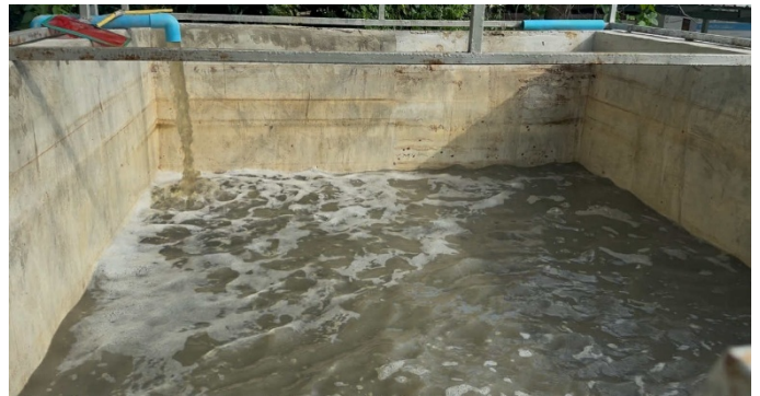
บ่อเก็บน้ำ และบำบัดน้ำทะเล ด้วยคลอรีน
