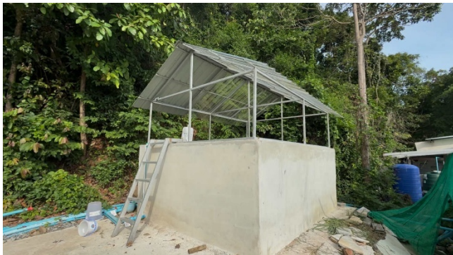
บ่อเก็บน้ำ และบำบัดน้ำทะเล ด้วยคลอรีน
