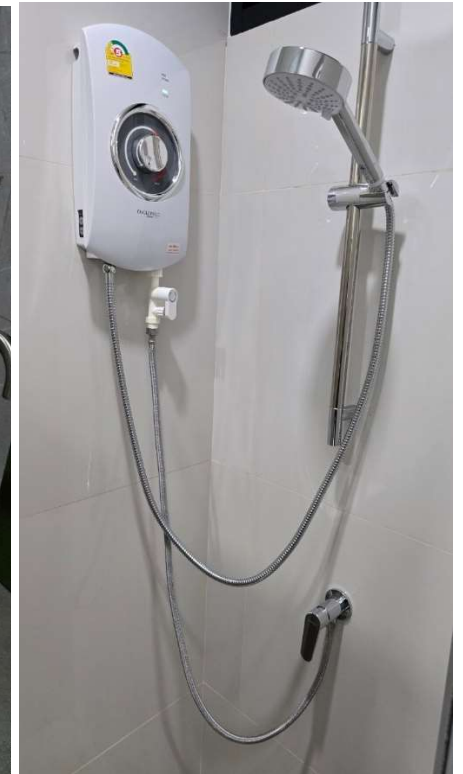
1.6 ฝักบัวปริมาณการใช้น้ำไม่เกิน 6 ลิตร/นาที
